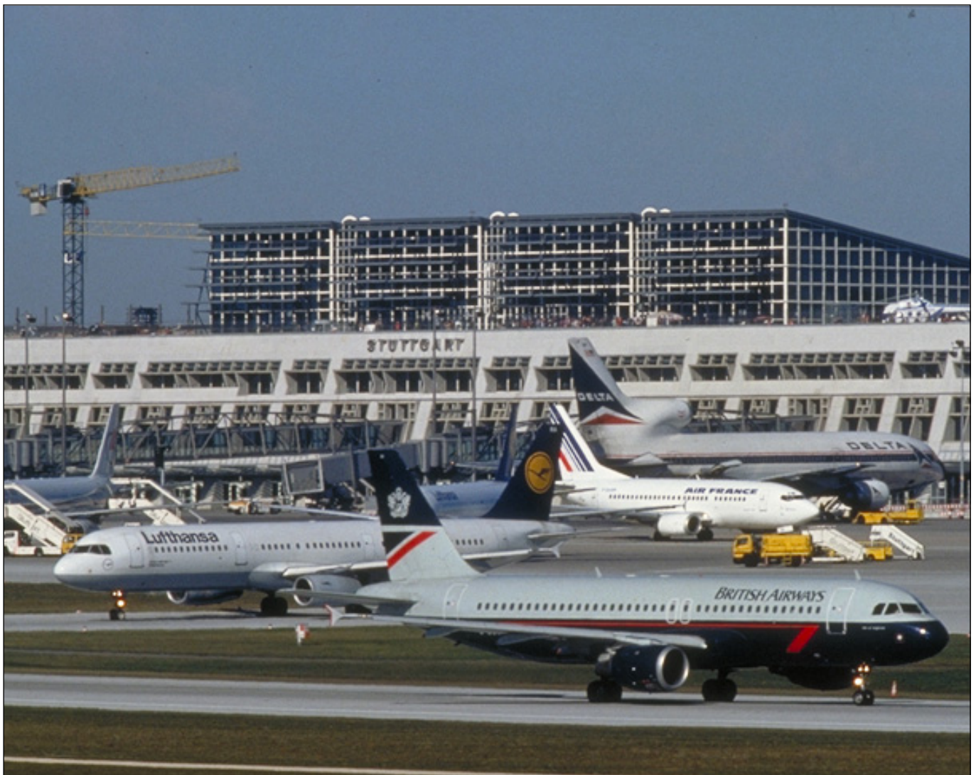
Bild: Blick auf das Vorfeld und Terminal 1 aus Richtung Süden (Bild: Flughafen Stuttgart GmbH)
